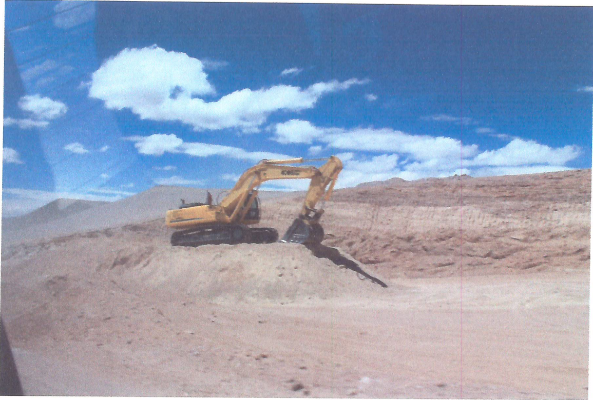
Excavadora en descanso, labor realizada en el lugar, corte de cerro por donde pasara el nuevo camino (modificación del trazado)
